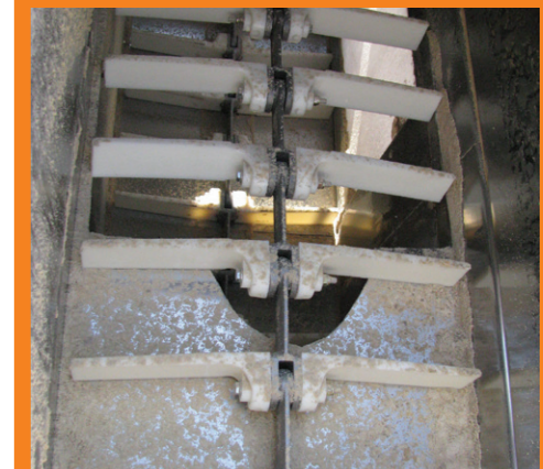
饲料厂中运行的采用尼龙叶片的 Bolt 'N' Go 组装式链条系统
