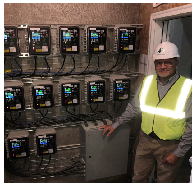
Несколько систем Watchdog Super Elite и узлов промышленного протокола Ethernet Flex-Net установлены в помещении управления
