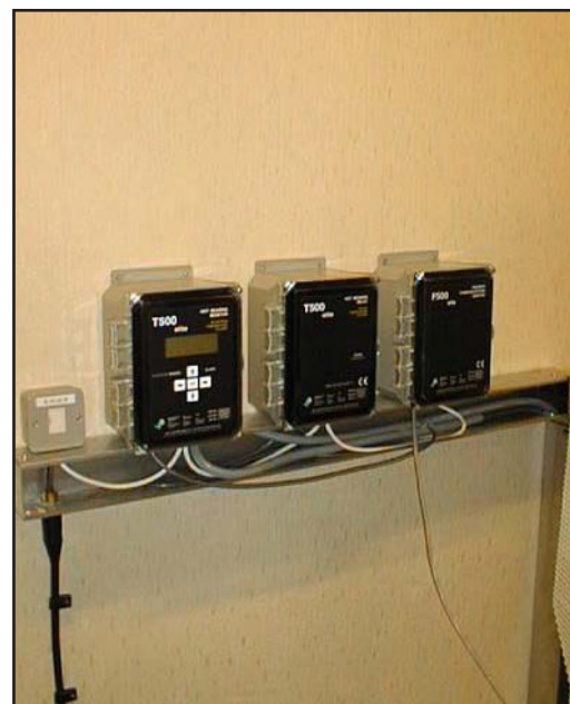
Система 4B HotBus™ установлена в диспетчерской
