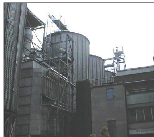
Complexo de silo
