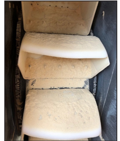
Elevatorbecher mit übermäßigem Verschleiß
