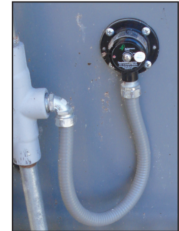
Touchswitch установлен на ковшевый элеватор
