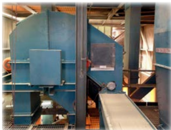
Image 4 : Chute de déchargement – après modifications
