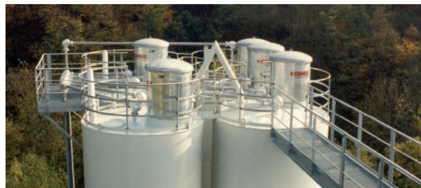
Dépoussiérage des silos avec STAFI®
