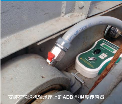
安装在输送机轴承座上的 ADB 型温度传感器
